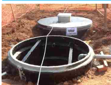
TANQUE P/ RESERVA DE INCÊNDIO
