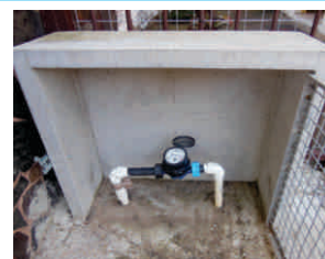
CAIXA P/ HIDRÔMETRO
