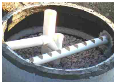
CAIXA DIVISÃO ESGOTO
