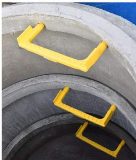
Os degraus para escada de serviço são usados para acesso a estruturas subterrâneas como poços de visita, bombeamento, bacias de retenção e tanques em geral, contando com um plástico extremamente resistente à corrosão.
